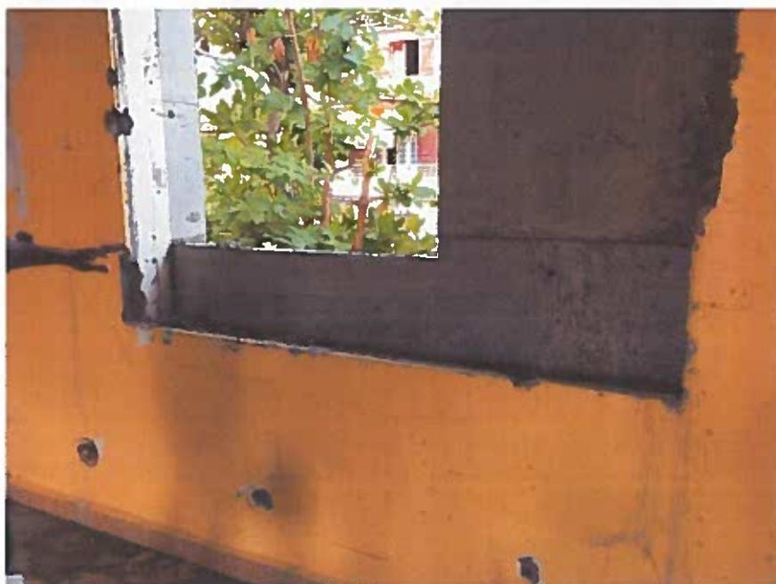
Comme le montre la photo ci-dessus, les allèges existante dans le voile de l'axe 1 n'ont pas la même hauteur que celle que nous avons réalisé en voile agrafé en axe Of. Il y donc lieu de les remettre à niveau, pour un montant total de **2 977,00 € HT**
