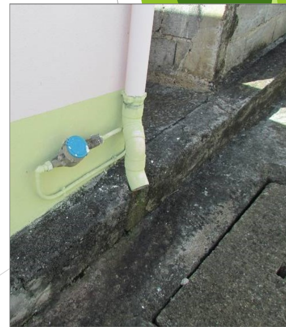
tuyau interrompu avant la bouche d'évacuation
