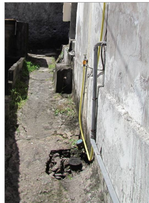
des habitations majoritairement dotées de l'eau potable, mais présence de raccords à mettre aux normes
