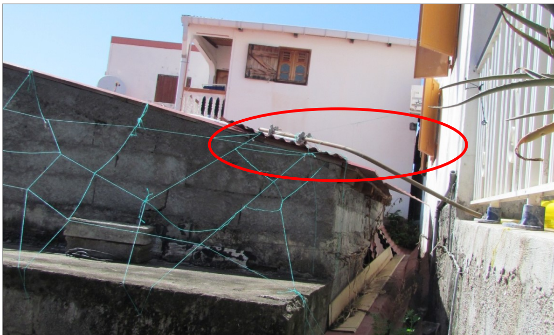
des habitations majoritairement dotées de l'eau potable, mais présence de raccords à mettre aux normes
